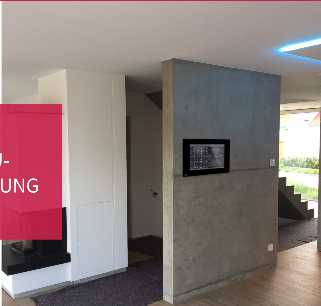
EINBAU EINES PEAKNX CONTROLPRO IN EINE SICHTBETONWAND
